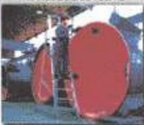
RECUBRIMIENTO DE TANQUES
