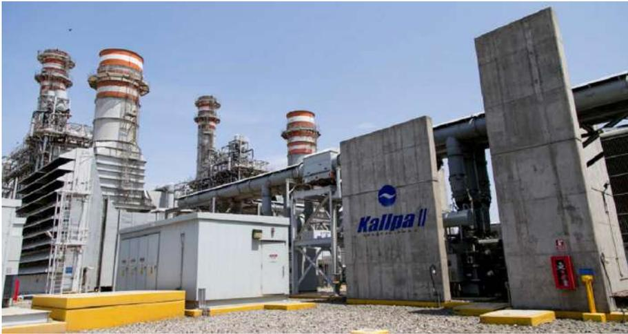
“Estamos en la fase final del proyecto de conversión a ciclo combinado de la Central Térmica Las Flores, con lo que pasaremos de 193 MW en ciclo abierto a 324 MW en ciclo combinado, y de una eficiencia del 37.5% a 57.2%”, detalla Irwin Frisancho, gerente comercial de Kallpa Generación.
